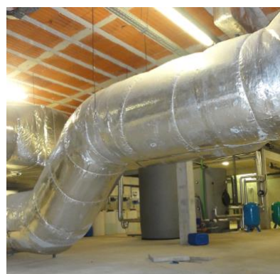
isolamento de condutas
