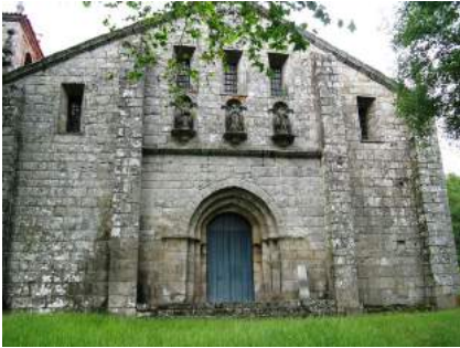
Fachada do Mosteiro de Fiães, Melgaço
