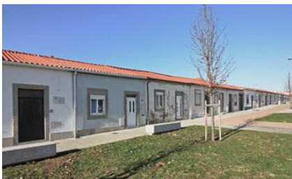
Casas de Pescadores no Campo da Agonia (Viana do Castelo) e Armazéns para aprestos marítimos em Areosa (Viana do Castelo). Fotos do Autor
