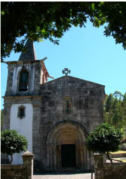
Fachada Principal da Igreja de S. Pedro de Rubiães
